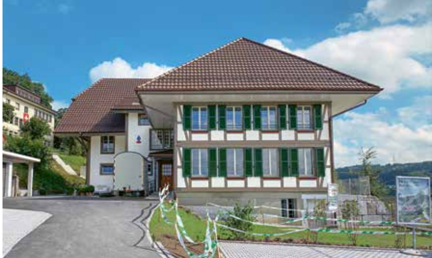
Das Schulhaus unmittelbar nach dem Umbau. Foto: Zumast AG
